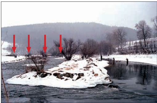
Foto bei der Grenzvermessung 1987. Im Hintergrund zu erkennen (rote Pfeile) die ehemaligen Brückenpfeiler Quelle: Helmut Vogl
