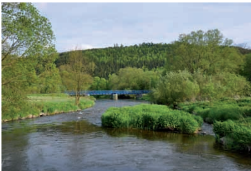
Neue Brücke, Aufnahme 2010 Quelle: Bayerische Vermessungsverwaltung
