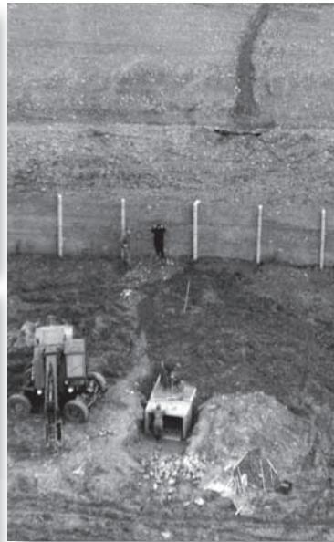
Bau eines Einschleustunnels (ca. 1975) Quelle: Bundespolizeidirektion Süd
