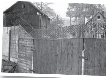
Holz und Betonelemente mit Abweisern, Mödlareuth 1964
