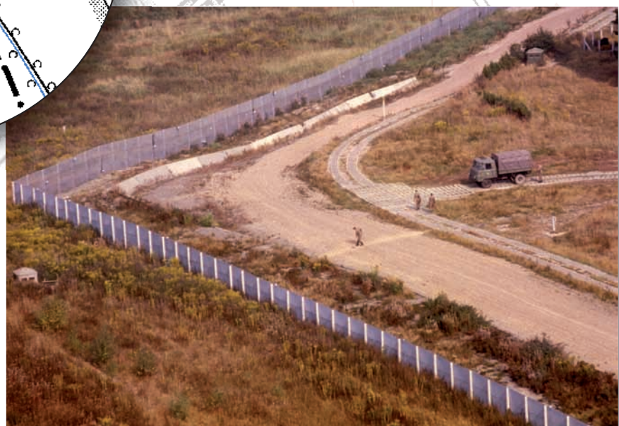
Sperranlage mit Einschleustunnel bei Hönbach Quelle: Bundespolizeidirektion Süd
