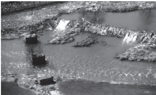
Brückenpfeiler der Brücke zum Gut Saalbach Quelle: Bundespolizeidirektion Süd
