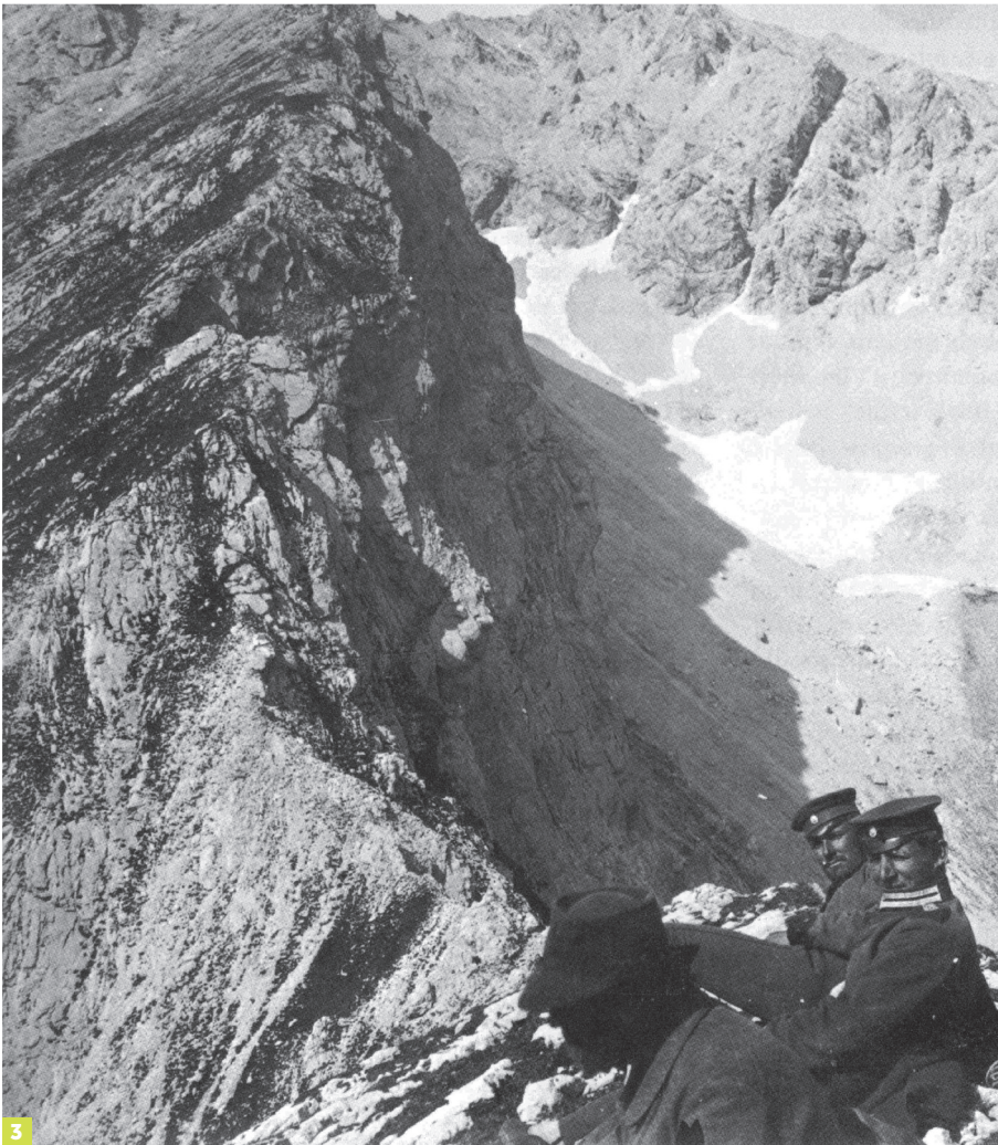
3 Gletschervermessung mit einem Phototheodolit am Brunnalkopf, 1892, Landesamt für Digitalisierung, Breitband und Vermessung
